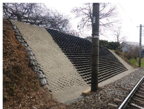
写真-1 ジオセル擁壁工法（左：復旧前 右：復旧後）
