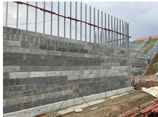
図-12 壁面材取付け状況
