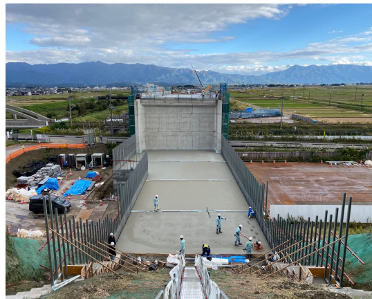
図-14 コンクリート床板打設状況
