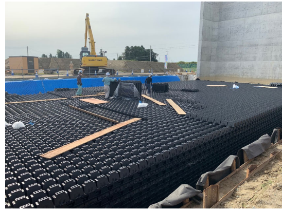
図-10 AR設置状況
