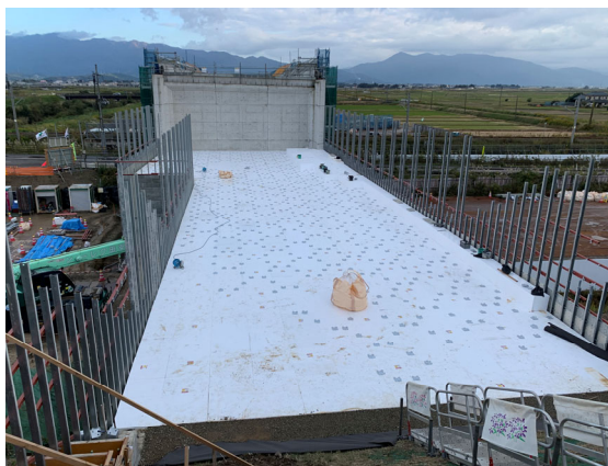
図-13 EDO-EPSブロック設置状況
