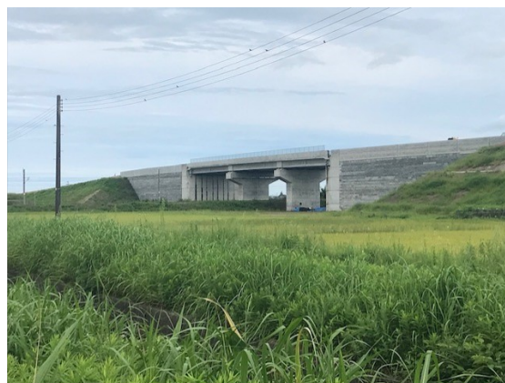
図-16 橋梁の両サイドにEPS盛土
