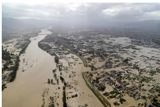
写真-1 河川氾濫・道路冠水
