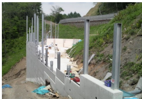
写真-4 EPS 拡幅盛土施工状況
