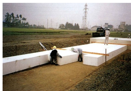
写真-3 EPS 盛土施工状況
