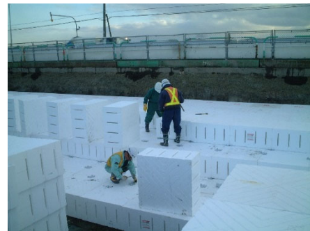
写真-7 施工状況
