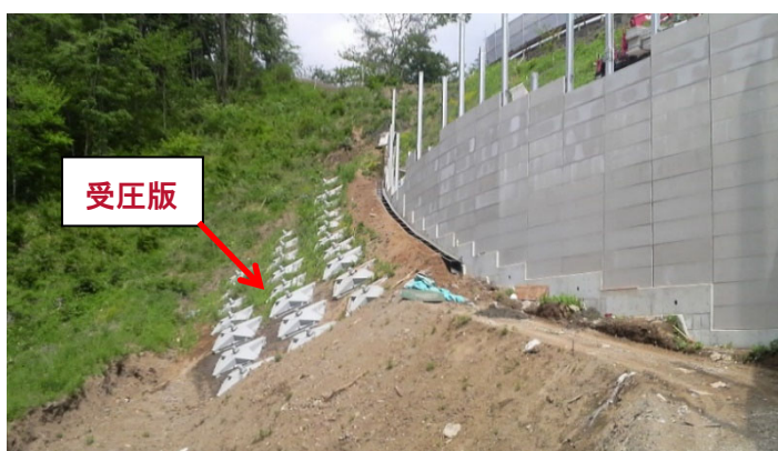
写真-8 施工事例
