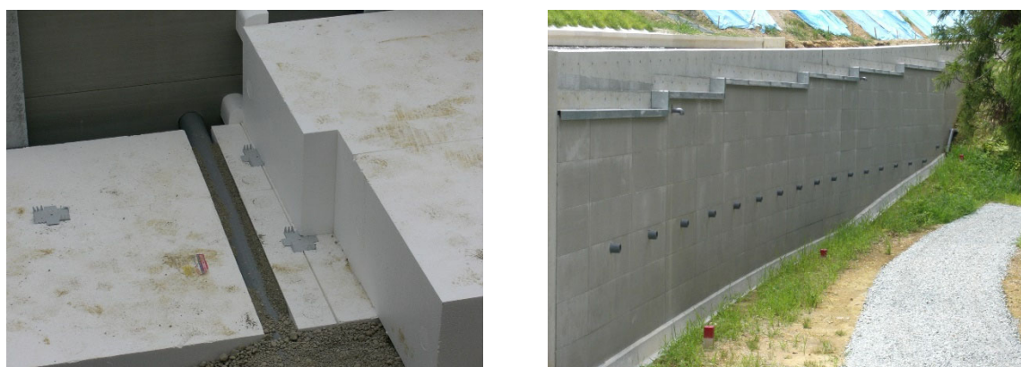
写真-10 湧水地における排水対策施工状況
