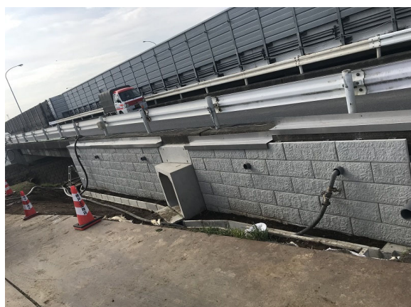
d) モルタル注入
