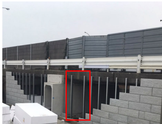
c) EDO-EPSブロック施工・壁面設置
