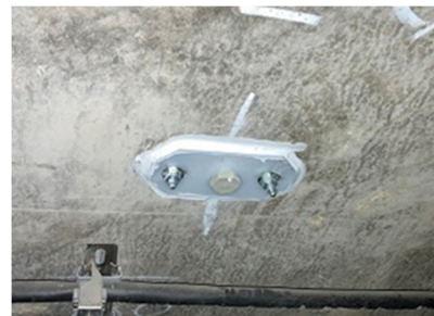
写真-13 ⑤目詰工
