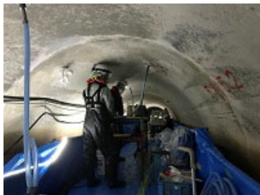
写真-14 水路トンネル
