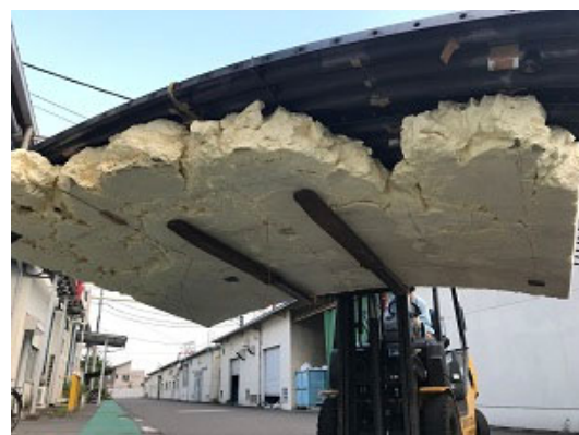
写真-9 解体後充填状況（下面側）
