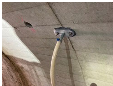
写真-12 ⑤注入工
