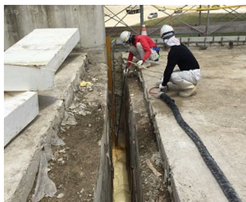
写真-16 橋台背面の空洞充填
