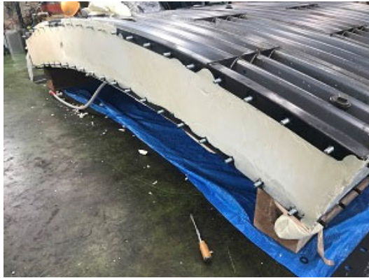
写真-6 充填状況（注入孔側）
