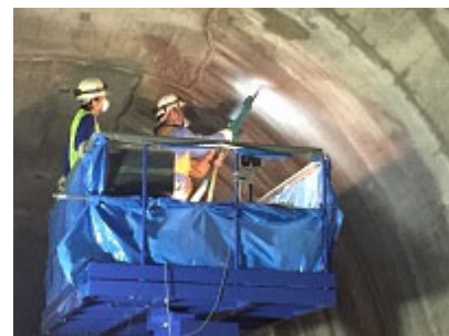
写真-10 ②削孔工
