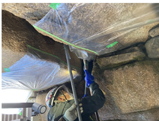
写真-17 古墳石積みの空洞充填
