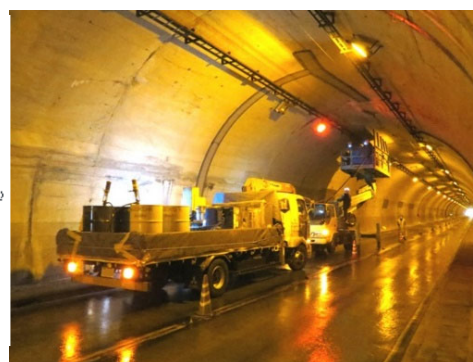
写真-1 片側車線規制での施工
