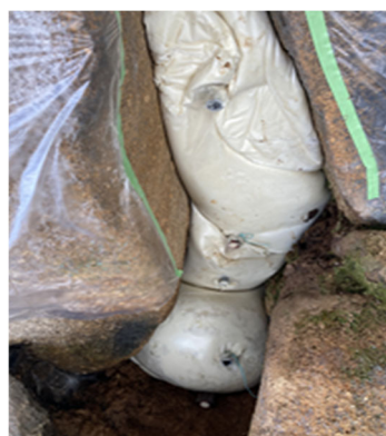
写真-18 ジュウテンバッグ内に注入
