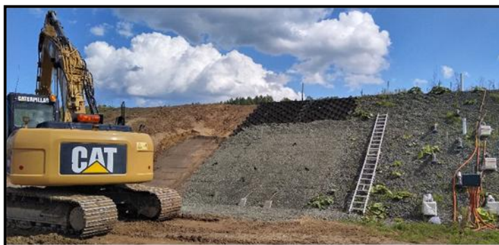
写真-1 新たに施工した斜面安定工
