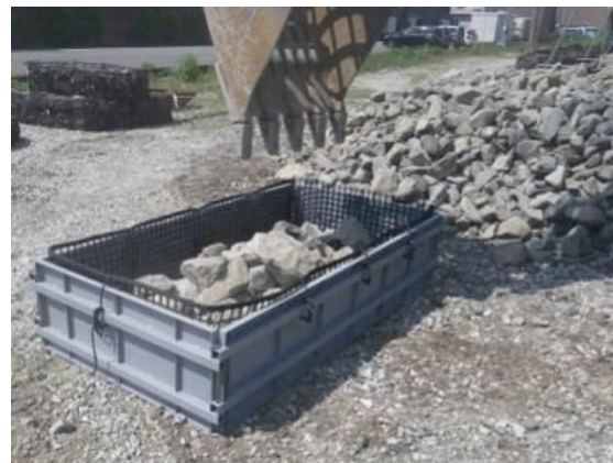
b) 中詰め材の投入（半分の高さ）
