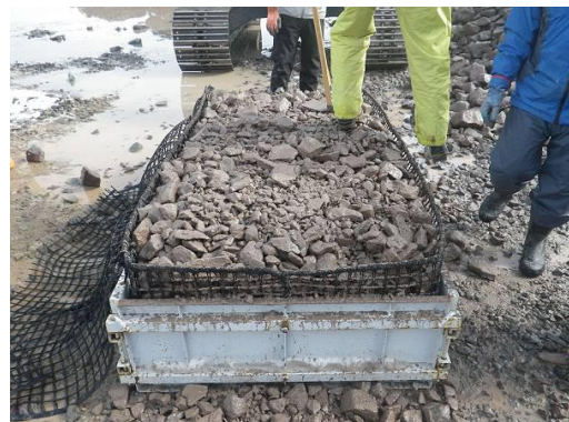
b)中詰め状況
