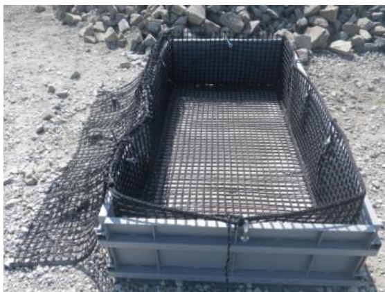
a) 専用型枠への設置
