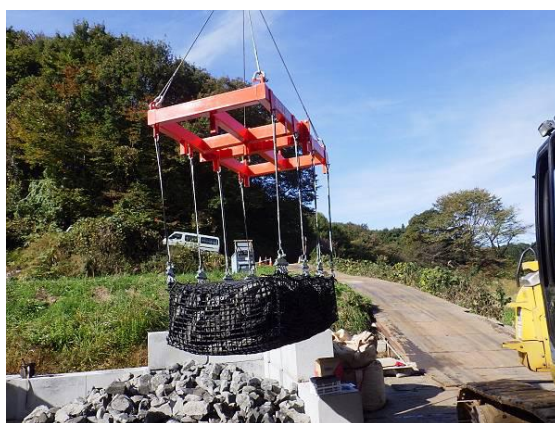
写真-1 吊上げ施工の様子
