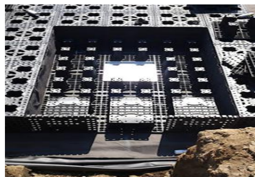
写真-4 土砂補足水透過壁システム
