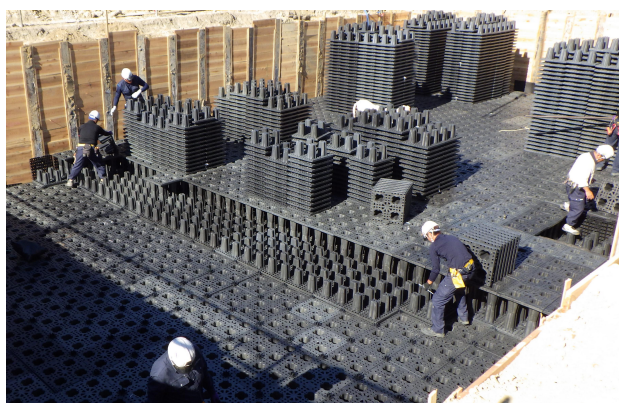
写真－1 ジオプール組立て風景
