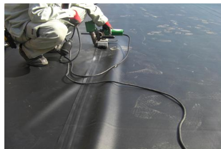
写真-6 遮水シート熱融着状況
