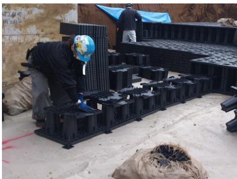
写真-3 ジオプール本体組立て状況
