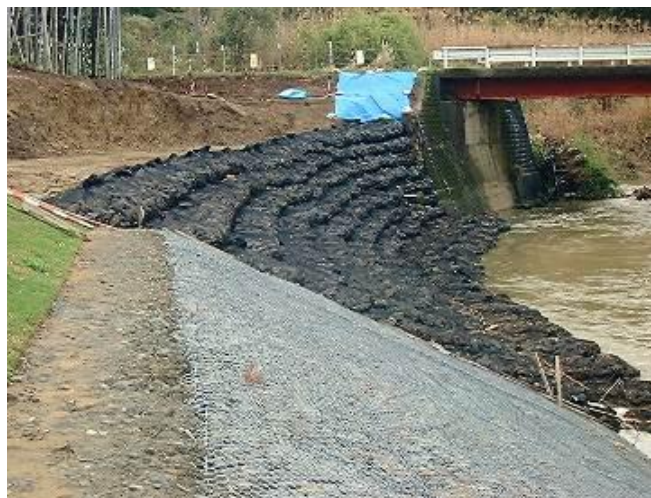
写真-5 河川災害復旧事例
