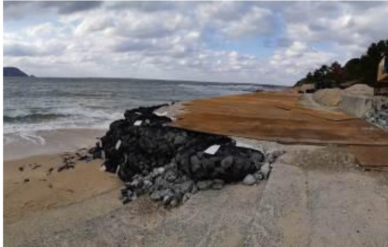
写真-6 ラブルネット積層工法を用いた海岸階段護岸復旧工事での基盤としての適用事例
