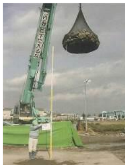
写真-3 吊上げ・吊下ろし性能試験
