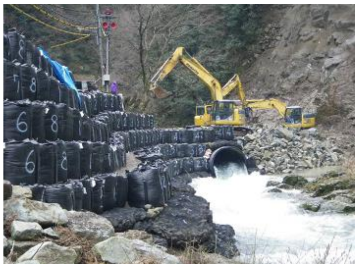
写真-7 耐候性大型土のうとの組合せによる災害復旧事例
