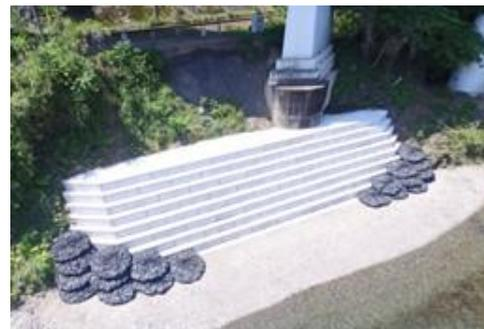
写真-6 橋脚保護工コンバック®
