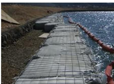
写真-7 調整池護岸コンバック®
