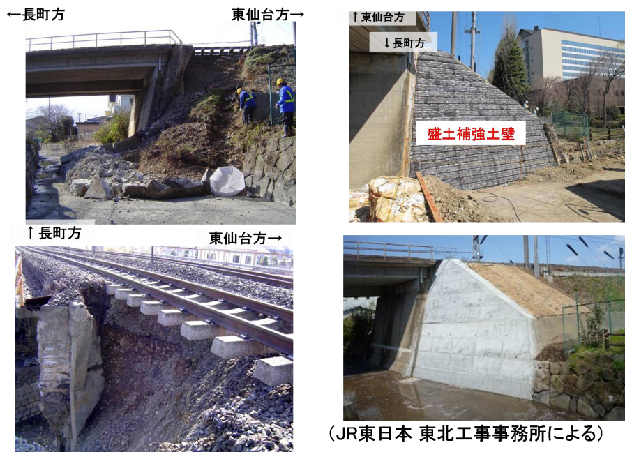
写真-10 東日本大震災によって被災した盛土および土留め壁の「RRR-GRS 構造物」による強化復旧事例 7)
