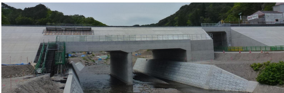
写真-13 三陸鉄道島越駅付近における「RRR-GRS ボックスカルバート」による強化復旧事例 4),5)
