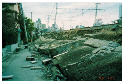
地震後の崩壊状況
