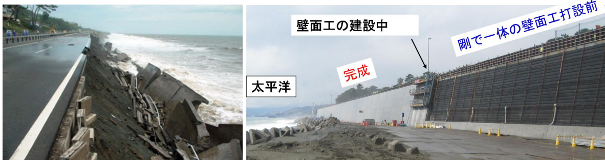
図-3 重力式擁壁と「RRR-GRS構造物」の洗掘による崩壊パターンの比較
