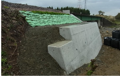
(c) 壁面コンクリート施工
