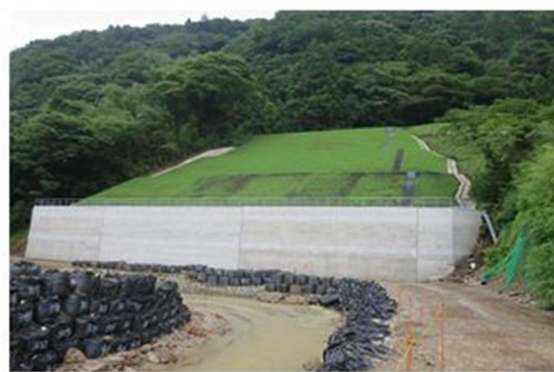
写真-8 「RRR-GRS構造物」による代表的な復旧工事 8) (西日本旅客鉄道(株)提供)
