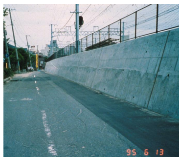
図-4 1995年兵庫県南部地震によるもたれ式擁壁の崩壊と「RRR-GRS構造物」による強化復旧事例 6)
