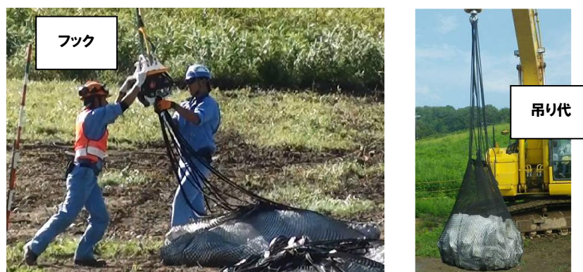
写真-11 作業性の向上
