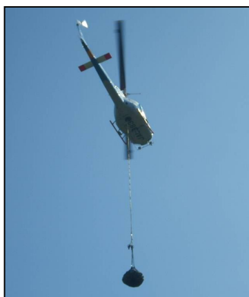
写真-9 空輸状況
