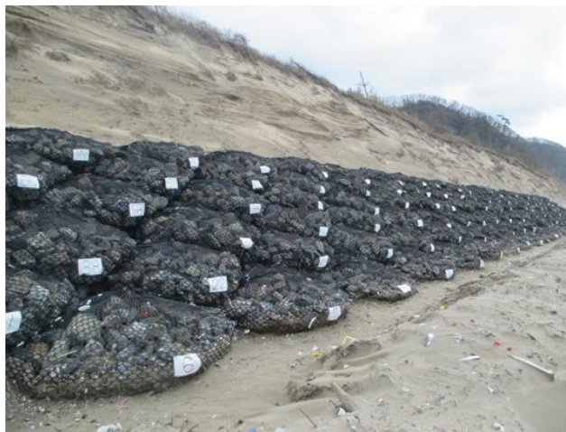
写真-13 海岸保全施設の応急復旧
