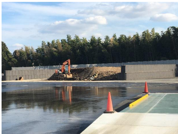
熊本県内での分別ヤード仕切り壁
