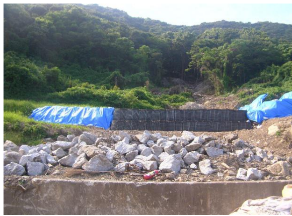
仮設土留め壁
