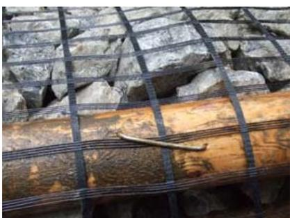
写真-3 木工沈床
