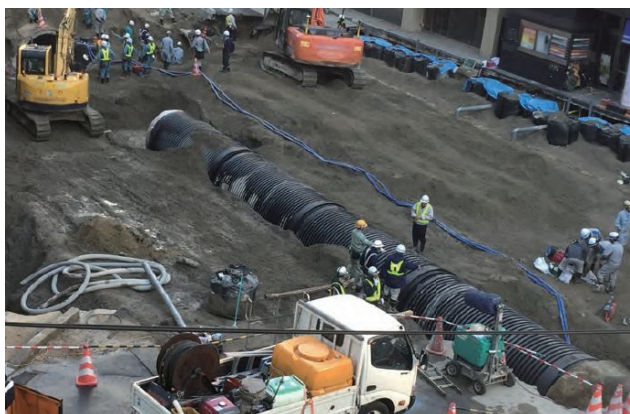
図-2 ハウエル管による復旧状況
