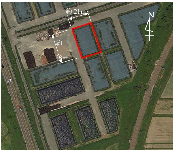
写真-5 仮置場全景(赤線囲みが測定対象ブロック)
