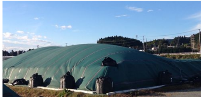
写真-4 風によるGPWSの変形(北東角より)
