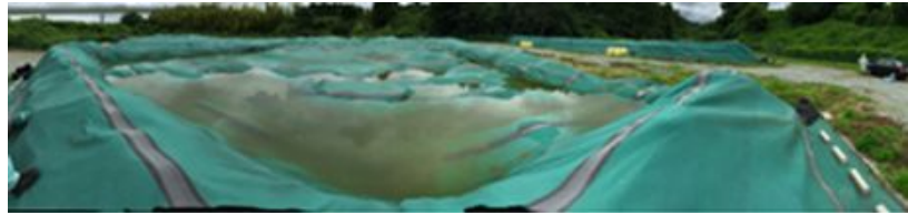
図-10 キャッピング上部に生成した雨水溜まりの様子
