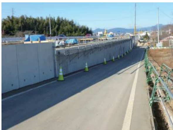
大型 VIG パネル®の施工例
