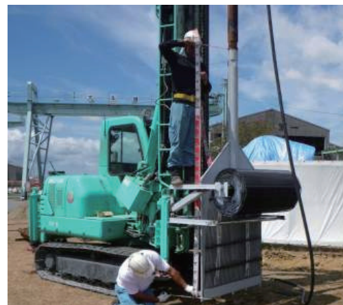
ジオグリッドの打設状況
