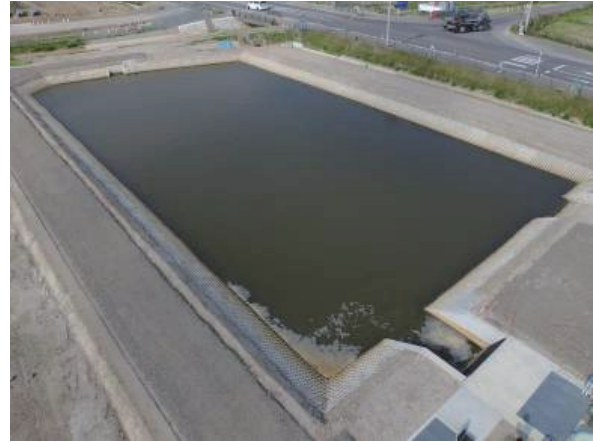
ゴビマット®による復旧事例（排水機場）
