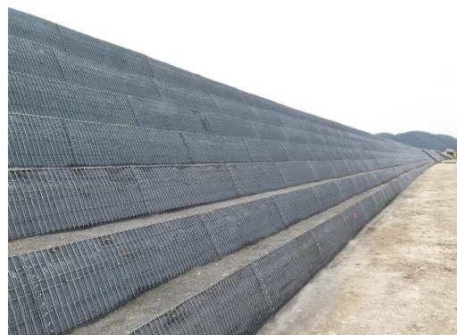
壁面設置完了
