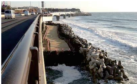
写真-2 海上仮設道路
