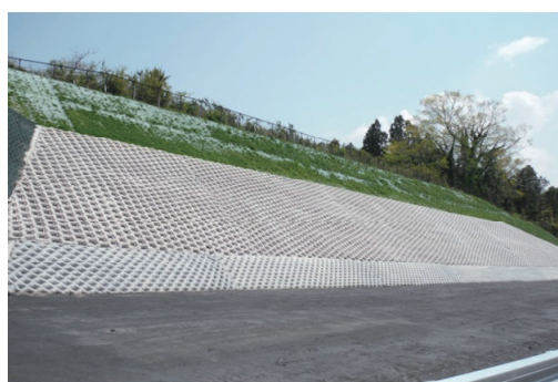
写真-5 道路法面
