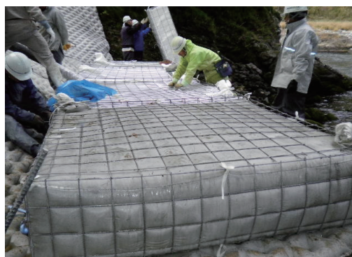
写真-6 注入後のコンバック®
