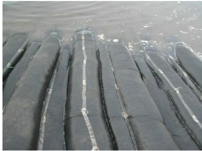
施工直後の状態
