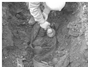
写真-3 敷網の撤去状況
