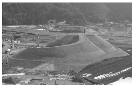
写真-2 盛土完了全景
