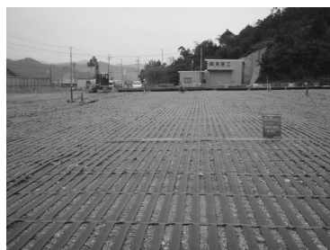
写真-1 敷網工敷設状況
