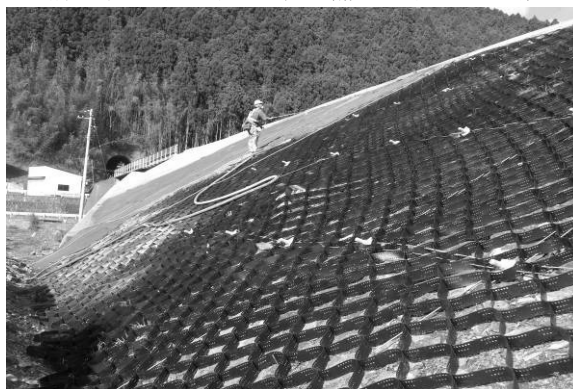
図-5 RRS®工法の施工事例
