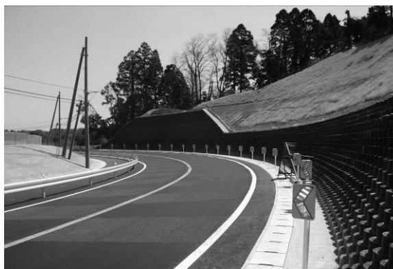
図-3 テラセル®擁壁工法
