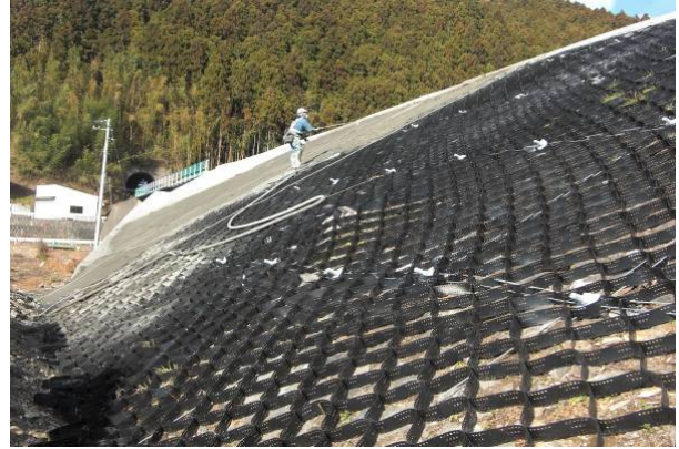
RRS®工法の施工事例
