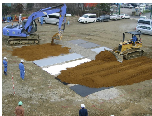
図-11 施工耐性実証実験の状況
