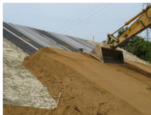
図-10 斜面安定性実証実験の状況
