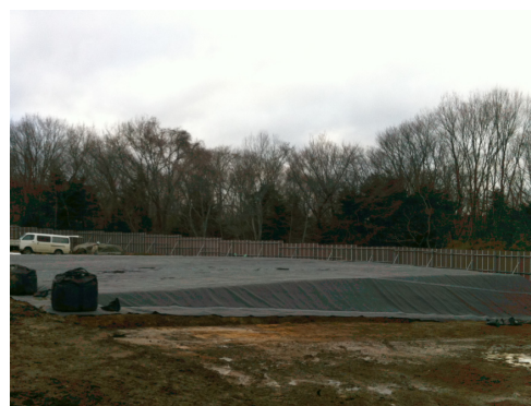
図-13 ガス透過性防水シートが適用された 除染廃棄物仮置場の施工状況 (2)
