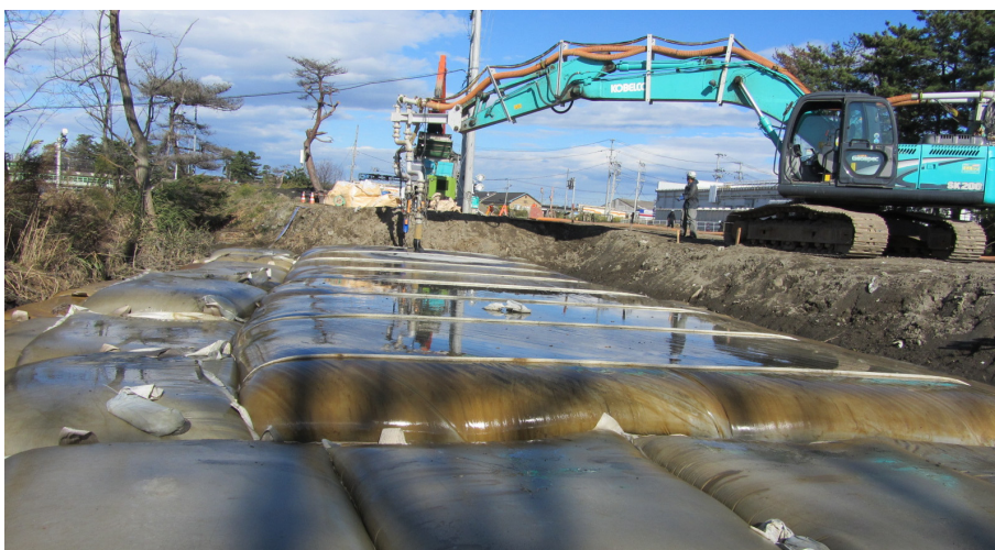
写真-1 施工中の 100m 3 袋（写真提供：㈱ピーエス三菱）
