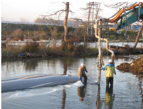
写真-2 施工中の 20m 3 袋（写真提供：(株)ピーエス三菱）
