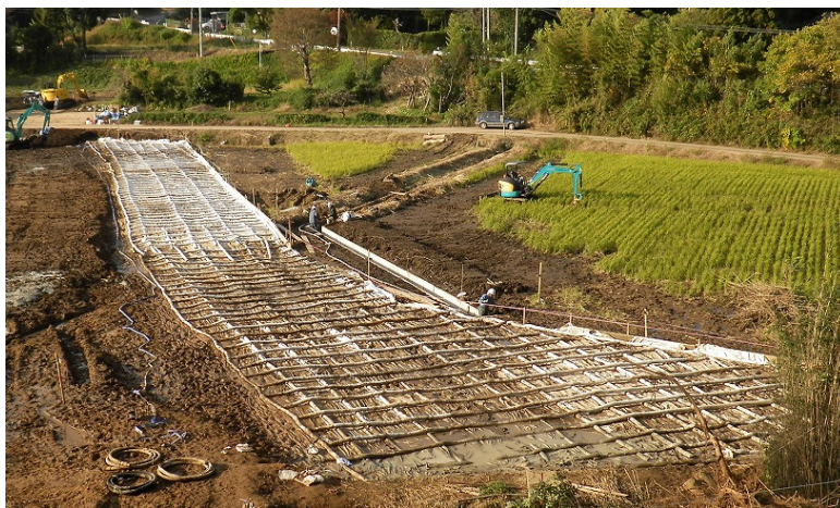
写真-3. パレスシート施工状況
