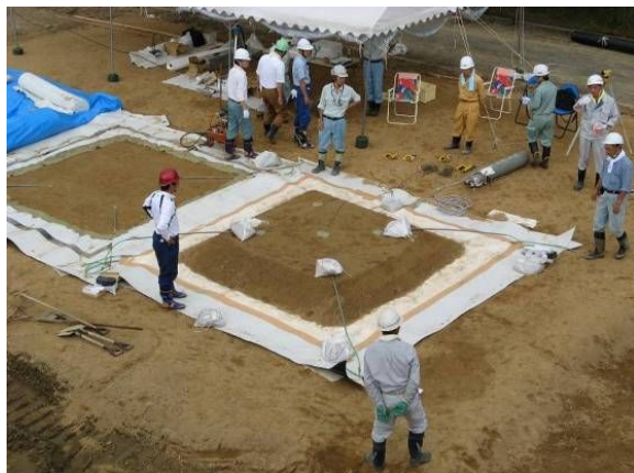
ガス透過性実証実験の状況
