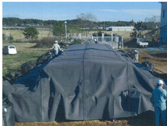
ガス透過性防水シートが適用された 除染廃棄物仮置場の施工状況
