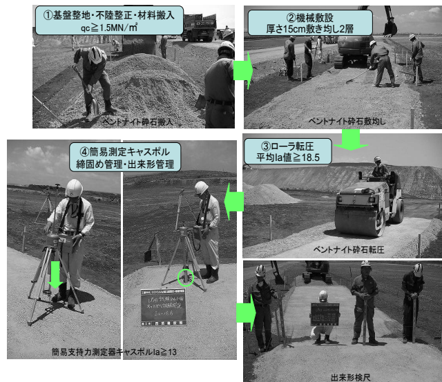
図-5 一次保管用底部施工フロー
