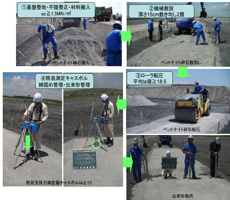
一次保管用底部施工フロー
