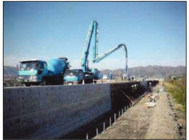
壁面工施工状況
