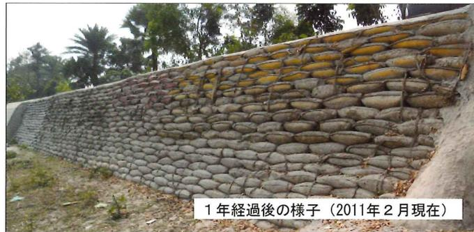
土嚢積層工法による農村道路の波浪侵食対策
