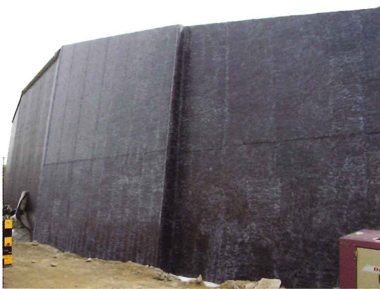
遮水壁の状況
