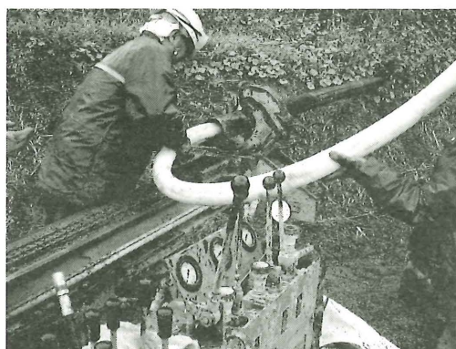
写真-3 ロジオドレーン施工状況
