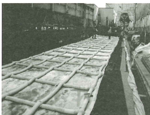
写真-4 パレスシート施工状況
