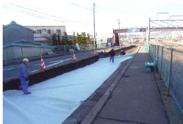
ジオテキスタイルの軟弱路床面への敷設
