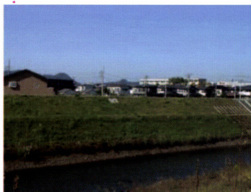
敷設1年9ヶ月経過状況
