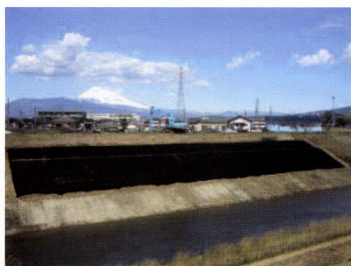
来光川仁田築堤護岸工事：敷設完了時
