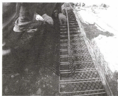
写真-3 ジオグリッド取付
