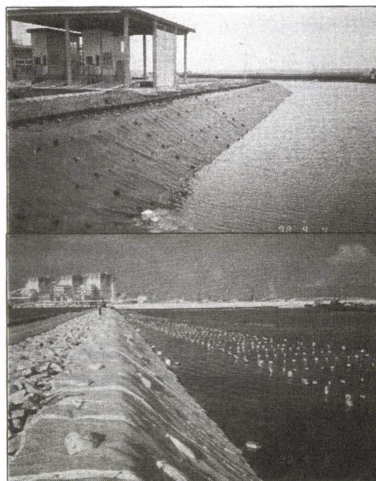
海面処分場遮水工への取り組み
