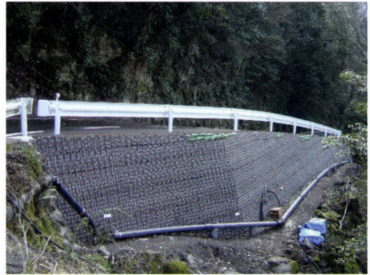
フラットパネル壁面材を用いた補強土壁
