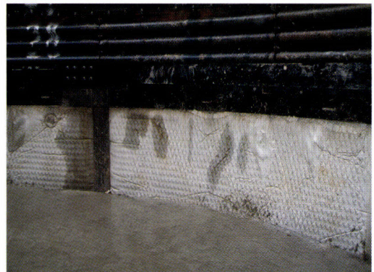
袋詰めモルタル覆工を用いた山留め工
