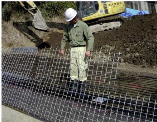
フラットパネル壁面材の取付け状況
