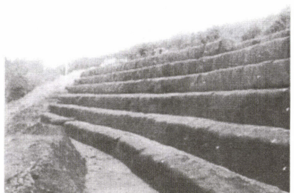
写真-10 盛土の完成状況（縦-10）
