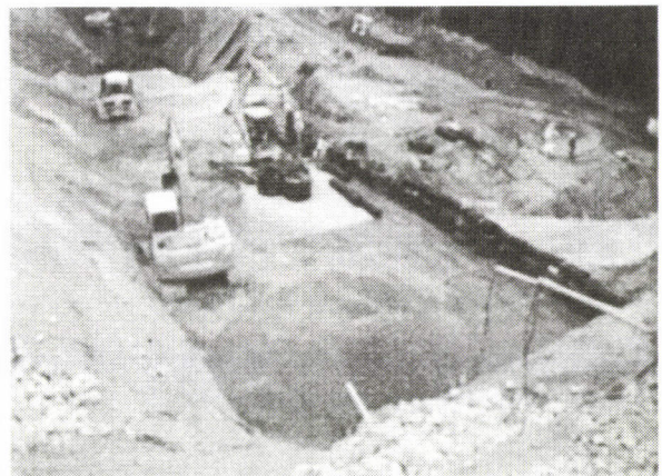
写真-6 盛土材のまき出し
