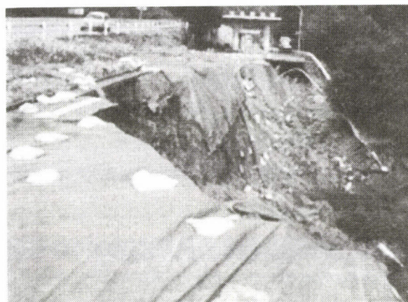
写真-1 盛土の状況 (縦-10)
