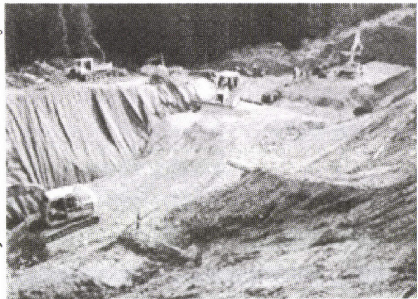
写真-5 置換え碎石の施工
