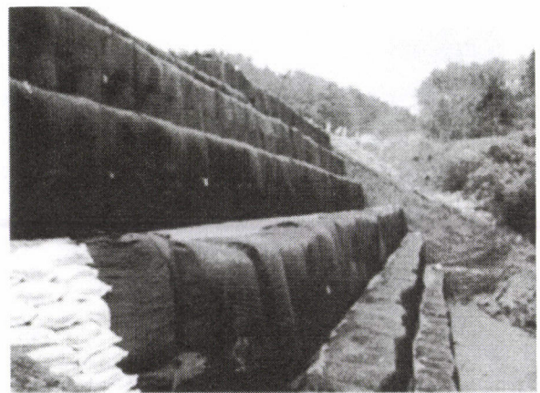
写真-8 ジオグリッドの巻き込み
