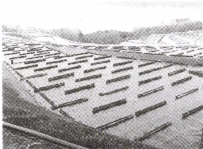
写真-6 施工風景
