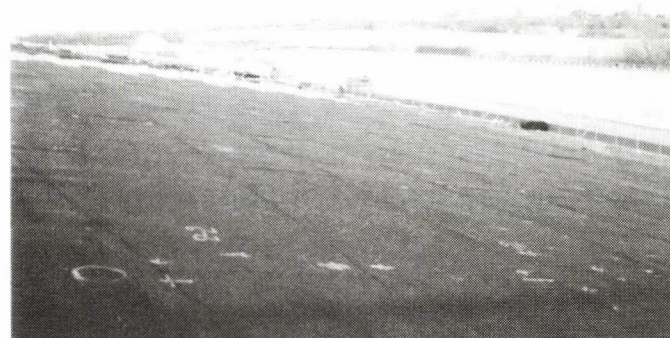
写真-2 継ぎ目部分の状態
