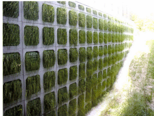
環境保全型直壁
