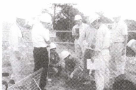
写真-1 補強土壁の現場
