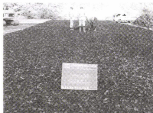
写真-5：タイヤシュレッズの盛土透水層施工
