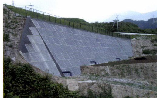
造成工事への適用事例 (5分勾配)
