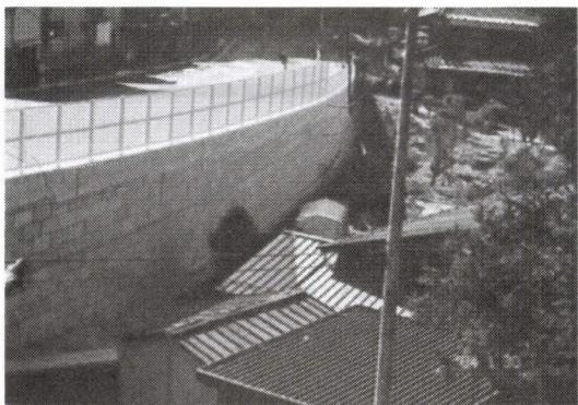
バリアフリー対応で、交通量が多い国道の歩道部を拡幅。既設石垣を崩さず、また重機を使わず隣接する民家への影響を極力少なくする事が出来ました。
