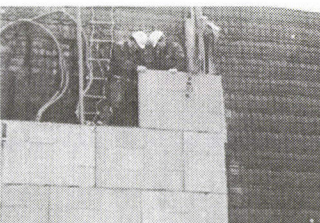
写真-14 壁面材取付け
