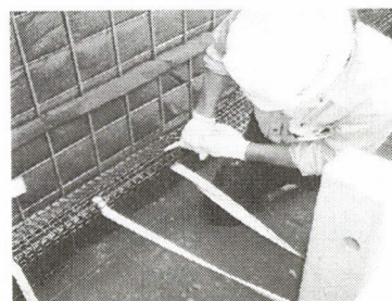
写真-4 連結ベルト設置
