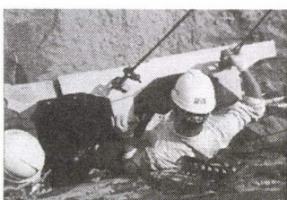
写真-12 壁面材撤去
