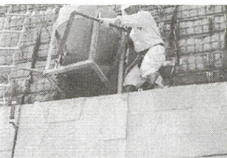
写真-16 碎石投入
