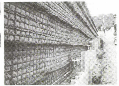
写真-5 ブロック設置状況
