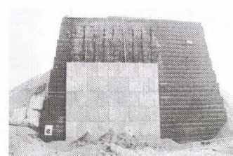
写真-13 壁面材撤去完了
