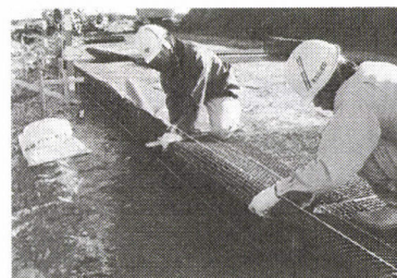
写真-2 ジオグリッド敷設
