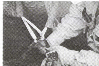
写真-15 壁面材連結
