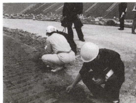
写真-7 ベントナイト混合土の感触を確認する見学者
