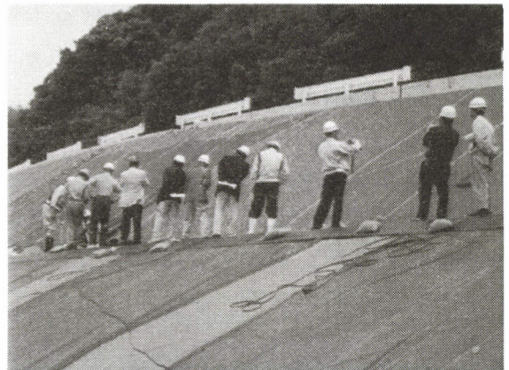
写真-3 遮水シート敷設状況の見学
