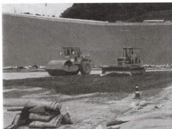
写真-6 ベントナイト混合土の敷設
