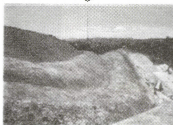
写真-4 田和山遺跡内環濠の斜面保護工として適用。複雑な地形でも適用可能。
