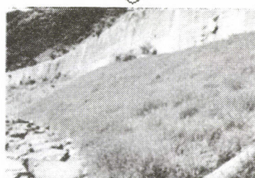
写真-5 四万十川の護岸保護工として適用。強い耐侵食性を生かし水没環境に適用。
