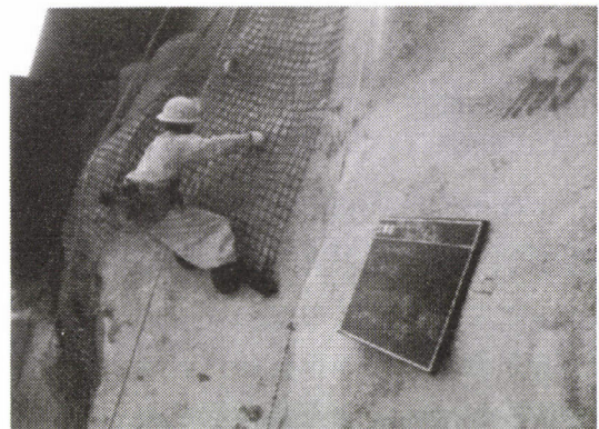
図-7 アラミド繊維グリッド設置状況 1
